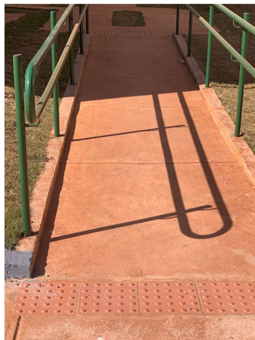
Figura 14 – Rampas de acesso e Guarda-corpo
