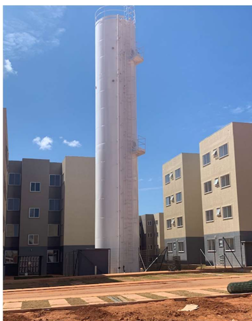
Figura 22 - Castelo d'água (Reservatórios Inferior e Superior)
