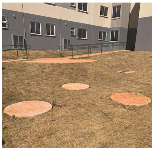
Figura 25 - Poços de Infiltração
