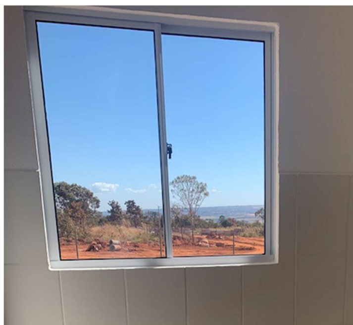
Figura 11 - Vidros das esquadrias
