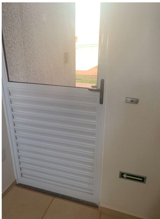
Figura 9 – Porta de Entrada dos Blocos
