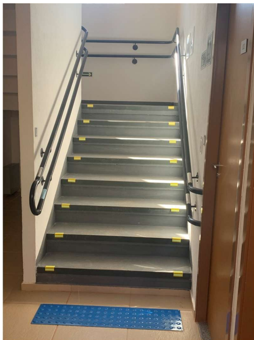
Figura 13 - Corrimão da escada
