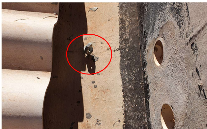
Figura 8 - Detalhe do ponto de ancoragem
