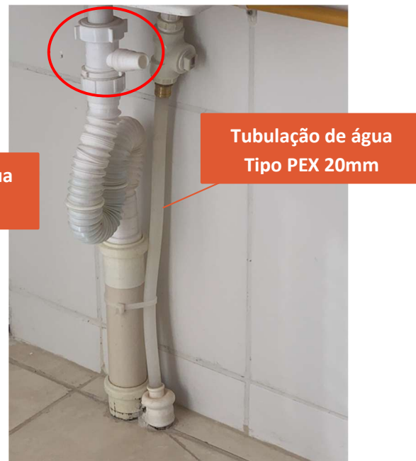
Figura 27 - Ponto para instalar a máquina de lavar roupa
