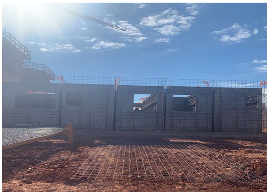
Figura 15 – Execução de parede de concreto
