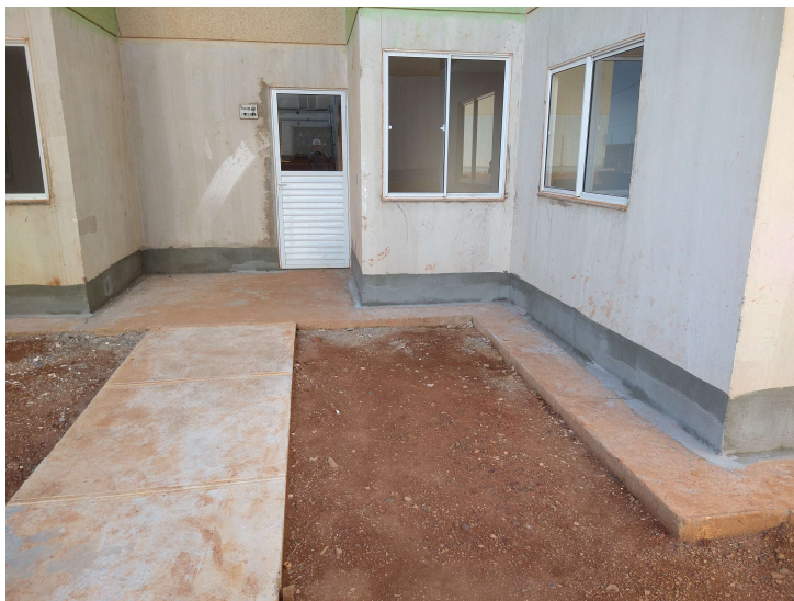
Figura 33 – Barra externa de impermeabilização dos blocos
